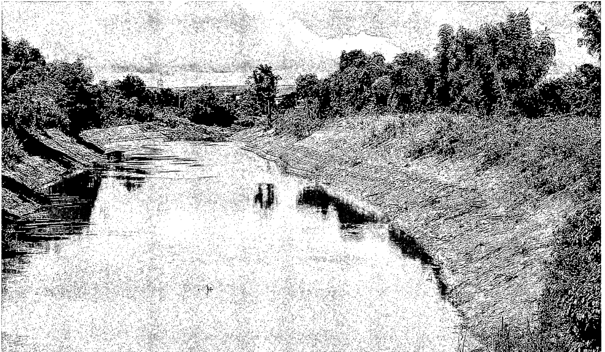
ภาพที่ ๓ สภาพภายหลังการขุดลอกแควหนุมานและการทำคันดิน (วันที่ ๙ พฤศจิกายน ๒๕๖๖)
