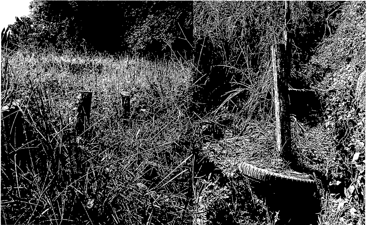
ภาพที่ ๕ การใช้ยางรถยนต์และไม้เสริมคันดินบริเวณแควโสมง ตำบลเมืองเก่า อำเภอกบินทร์บุรี จังหวัดปราจีนบุรี (วันที่ ๙ พฤศจิกายน ๒๕๖๖)
